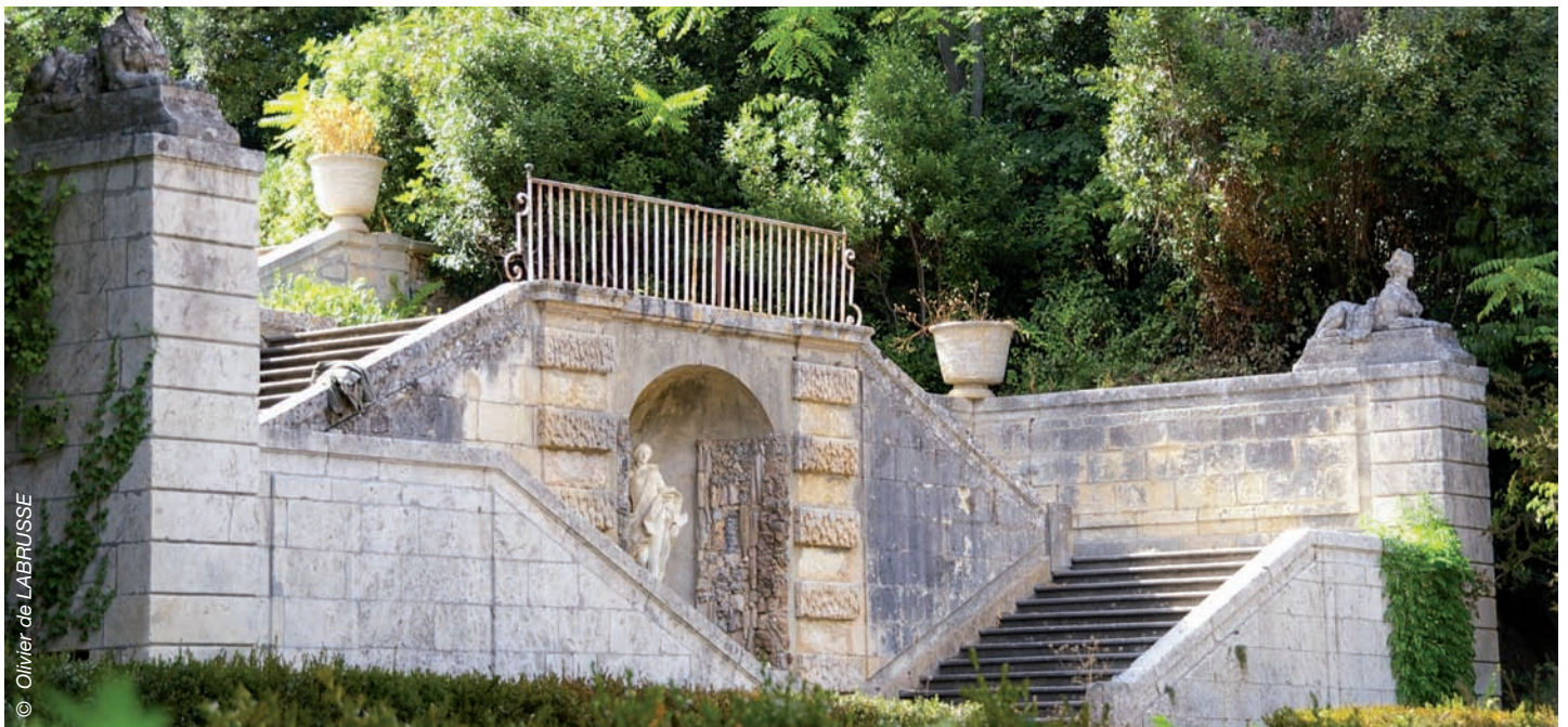
Ph. 33 Grand escalier
