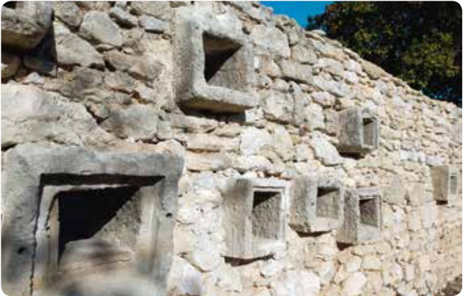
L'ANCIEN MUR RUCHER AU DOMAINE DÉPARTEMENTAL DE FONDESPIERRE
