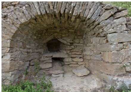
Four à chaux
