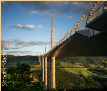
Viaduc de Millau
